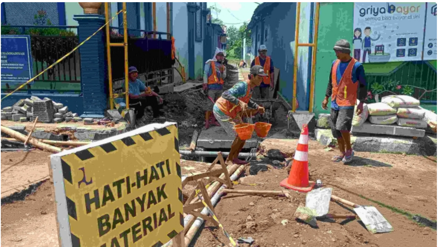
Pekerjaan pembangunan drainase di Banaran terus dikebut. (Foto:prijo atmodjo)
